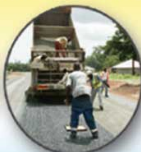
Amenagement de chaussées
